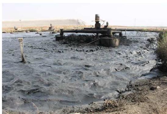
Figure 9 : agitateurs en fonctionnement – bassin biologique
