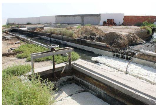
Figure 2 : canal d'amenée des eaux brutes
