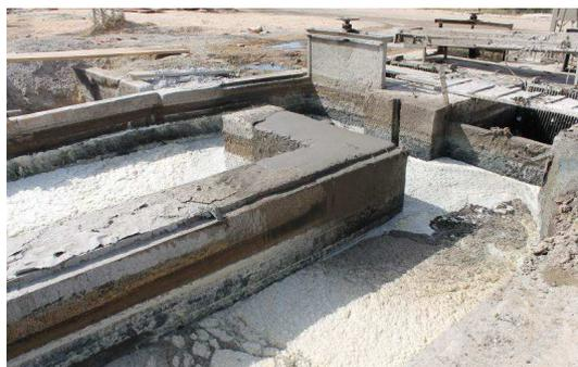
Figure 4 : graisses dans le canal d'amenée
