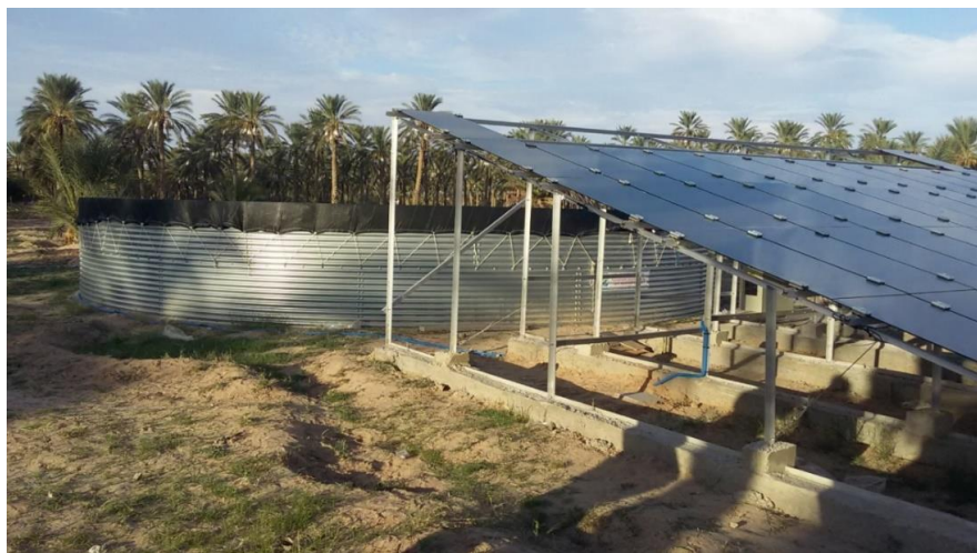
Installation panneaux photovoltaïques et bassin de stockage – Rjim Maâtoug
