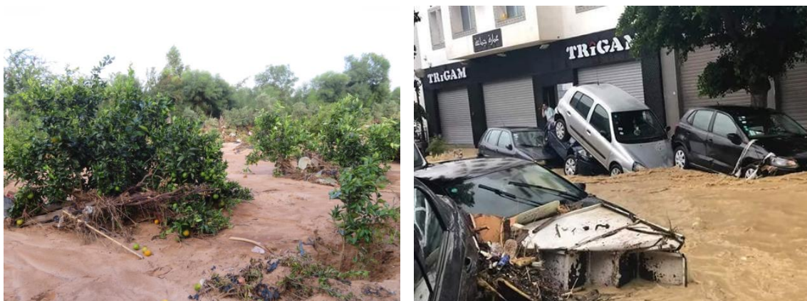
Dégâts causés par les inondations du 22 septembre 2018 à Nabeul (source CRDA)
