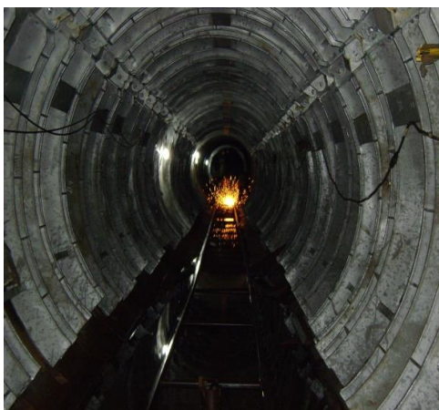
Galerie du barrage Barbara en cours de réparation
