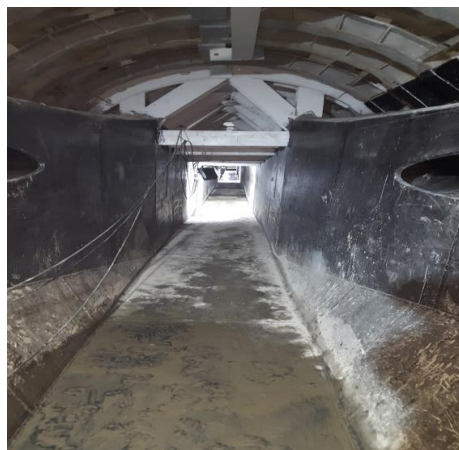
Galerie du barrage Barbara après réparation Photo prise le 5 mai 2018
