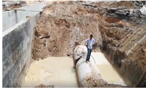
Casse de la conduite DN 1600 suite à la chute d'un engin du chantier RER à Cité Ezzouhour (4 juillet 2018, zones touchées par les coupures : le gouvernorat de Ben Arous, Ouardia, Kabaria, Monfleury, Turki et Belli)
