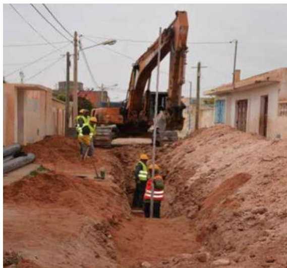
Travaux de l'assainissement dans des quartiers populaires
