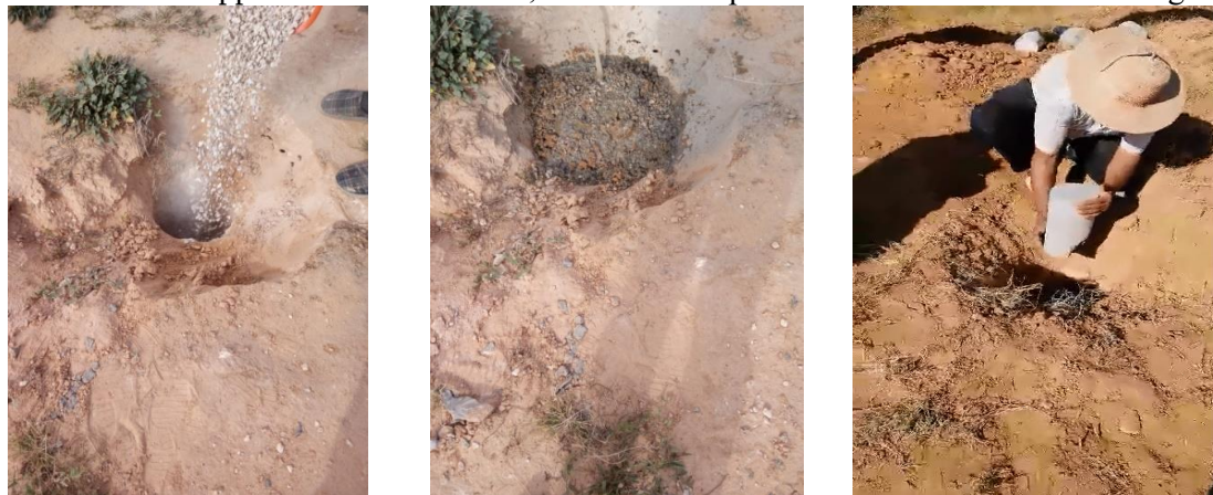
Bouchage de forages illicites à Sfax
