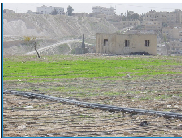
Figure 8 : Irrigation avec des eaux usées traitées près Amman en Jordanie – Ecofilae© Condom
