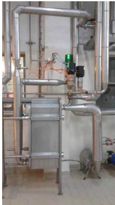
Traitement thermique du lait avant son ensemencement ©FAO/ Saaidia Bouali
