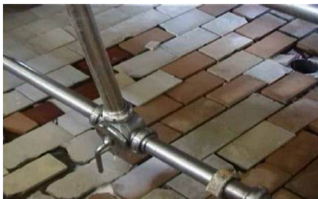
Fuite de lait au niveau d'une vanne ©FAO/ Saaidia Bouali
