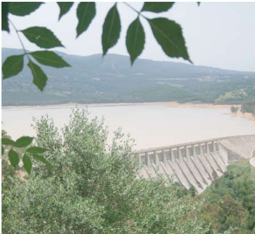
Vue sur barrage Bni M'tir
